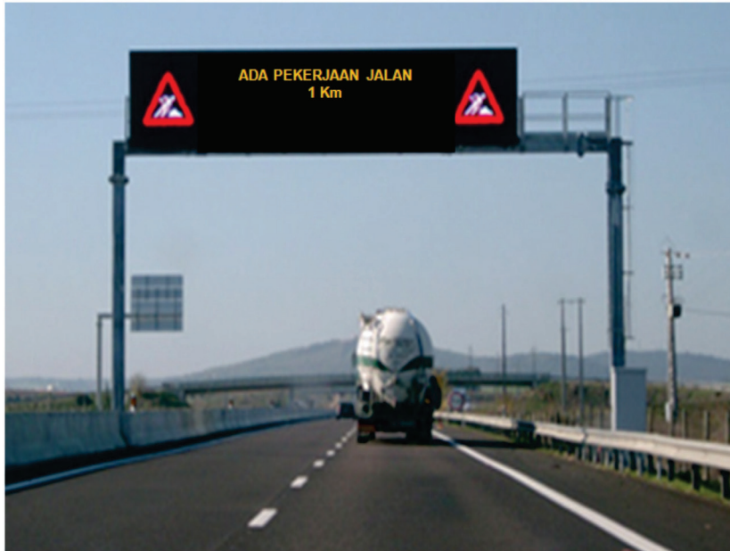
Gambar 3.10 DMS dan VMS secara permanen
