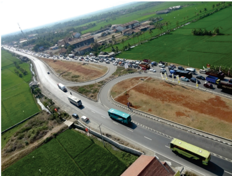
Gambar 2.5A Konflik pada fasilitas jalan putaran balik arah (U-Turn)
