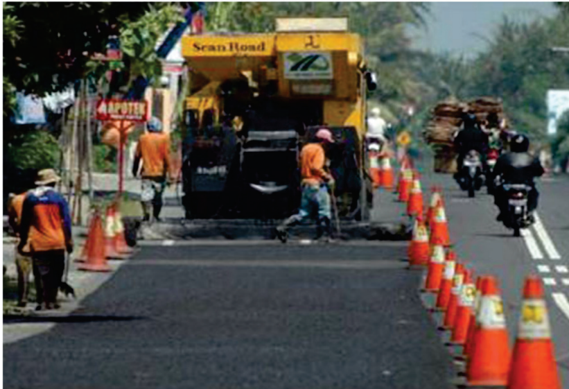
Gambar 2.8 Pekerjaan di ruas jalan
