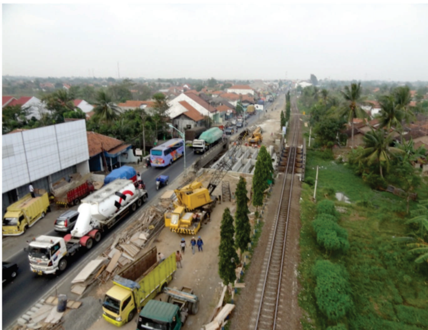
Gambar 2.9A Pekerjaan penggantian jembatan di Pantura Brebes
