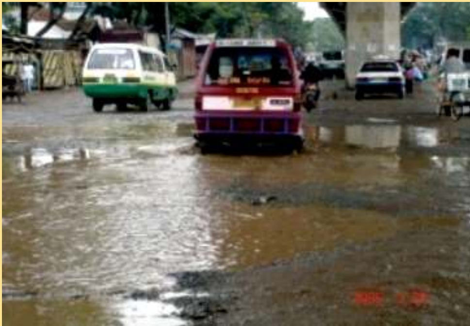
Gambar 7 - Kerusakan Jalan Lama Akibat Pembangunan Jalan Layang di Bandung
