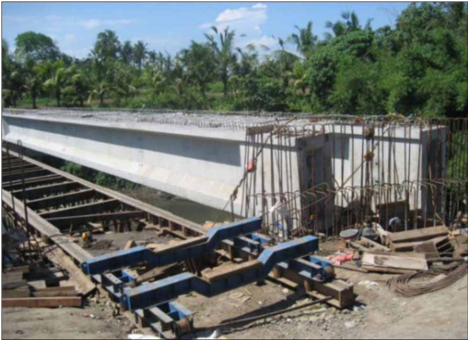
Gambar 4.35 Pemasangan Girder pada jembatan
