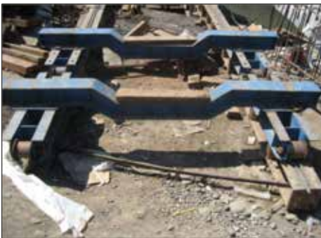
Gambar 4.38 Rel yang digunakan untuk membantu pemasangan girder
