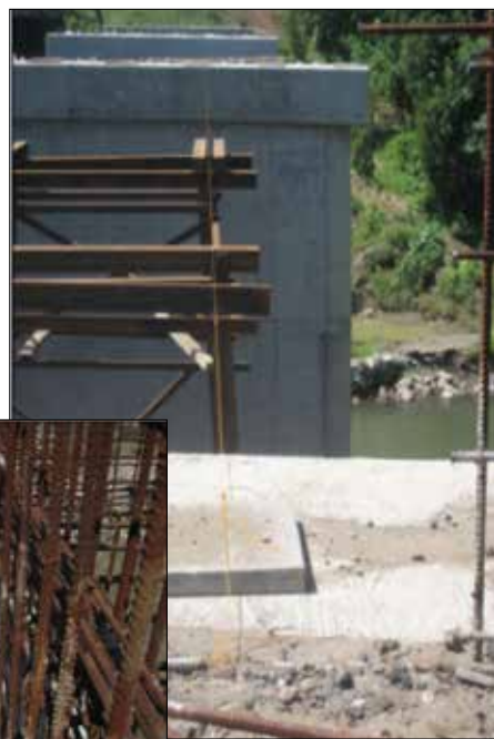
Gambar 4.34 Pengecekan sebelum pemasangan girder
