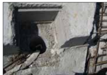
Gambar 4.14 Kondisi saluran drainase
