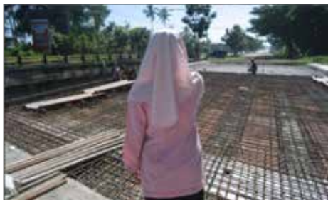
Gambar 4.8 Persiapan pengecoran pada bagian tengah jembatan
