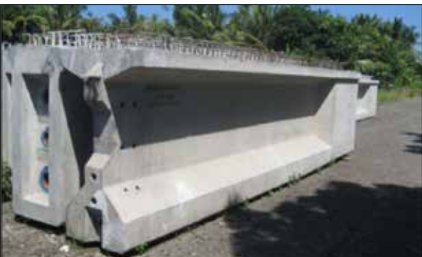
Gambar 4.27 Girder yang digunakan pada jembatan
