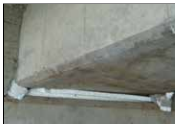
Gambar 4.13 Polystyrene foam pada tumpuan jembatan
