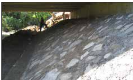
Gambar 4.4 Abutment pada jembatan Tukad Cekatung
