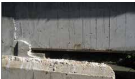
Gambar 4.5 Tumpuan pada jembatan Tukad Cekatung
