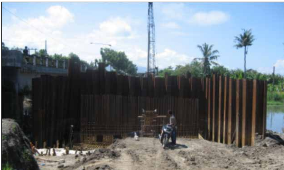
Gambar 4.23 Pemasangan Borepile pada Jembatan Tukad Udang-Udang
