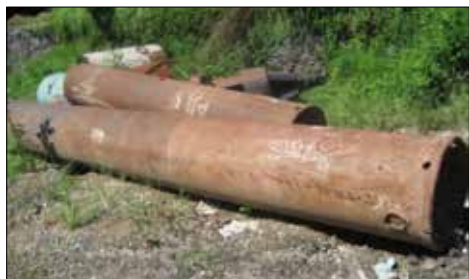
Gambar 4.28 Casing yang digunakan dalam pengerjaan Bored Pile
