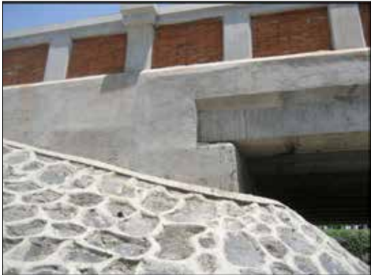
Gambar 4.48 Tampak Samping Hubungan antara gelagar dengan abutment pada jembatan integral Tukad Cucukan IV
