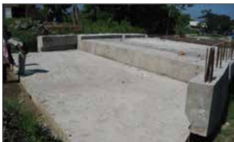
Gambar 4.10 Pelat Injak pada jembatan Tukad Panti
