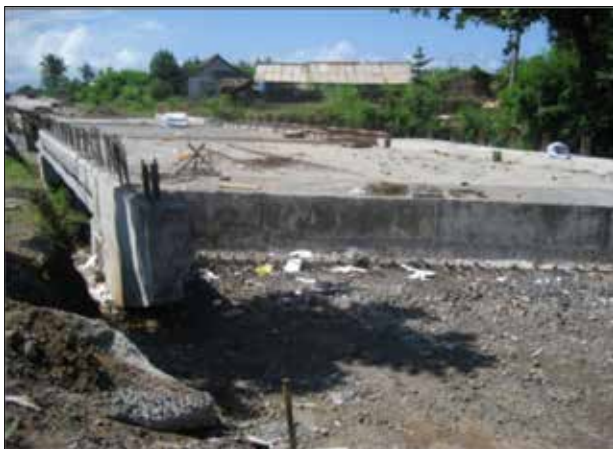
Gambar 4.29 Tahap Pelaksanaan Pembangunan Jembatan Tukad Mambang
