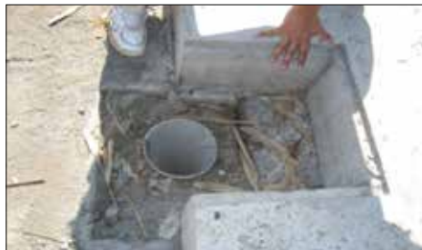
Gambar 4.6 Kondisi saluran drainase
