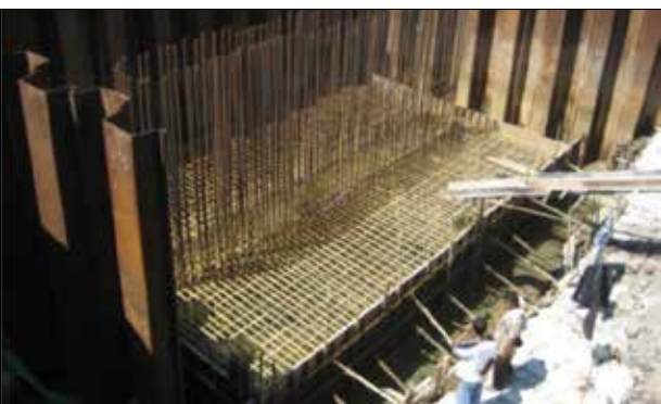
Gambar 4.24 Penulangan pada pile cap jembatan
