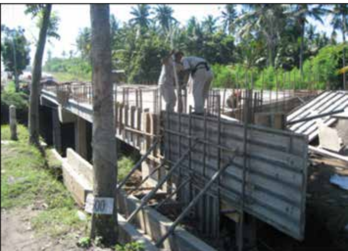
Gambar 4.18 Pembangunan Jembatan Tukad Cucukan III
