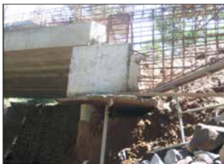
Gambar 4.16 Pembangunan abutment jembatan
