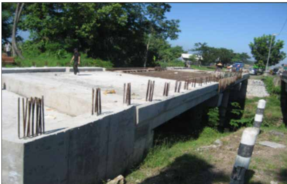
Gambar 4.7 Jembatan Tukad Panti
