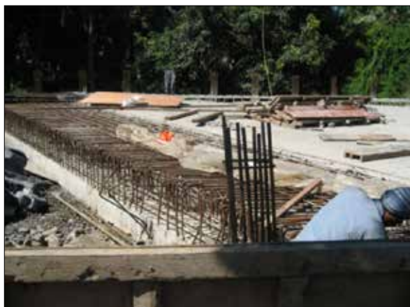
Gambar 4.17 Tahapan pelaksanaan pengecoran deck slab
