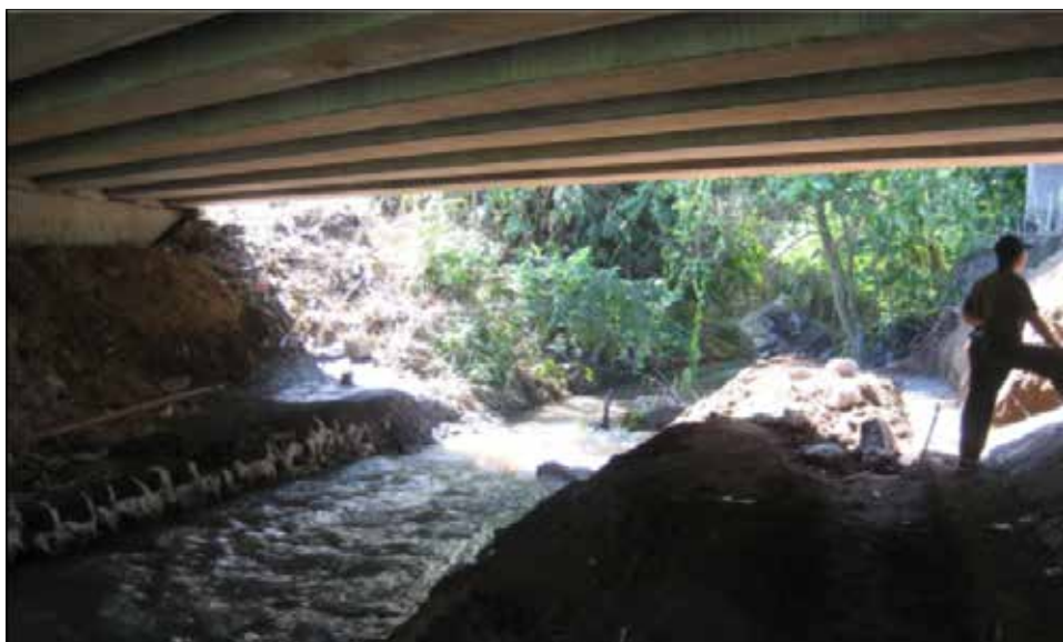
Gambar 4.2 Kondisi sungai pada jembatan Tukad Cekatung
