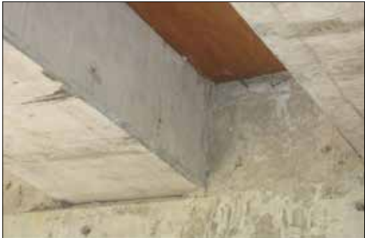
Gambar 4.47 Tampak Melintang Hubungan antara gelagar dengan abutment pada jembatan integral Tukad Cucukan IV
