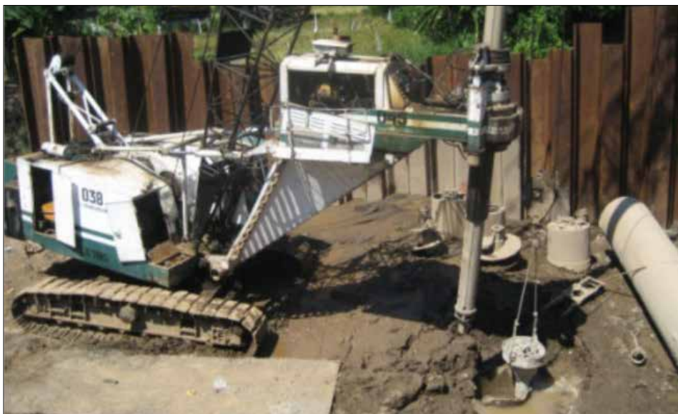
Gambar 4.26 Alat untuk instalasi Bored Pile
