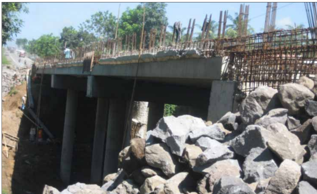
Gambar 4.15 Pembangunan Jembatan Tukad Loloan
