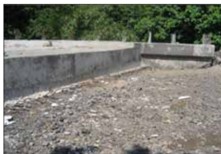
Gambar 4.30 Tahap pembuatan pelat injak
