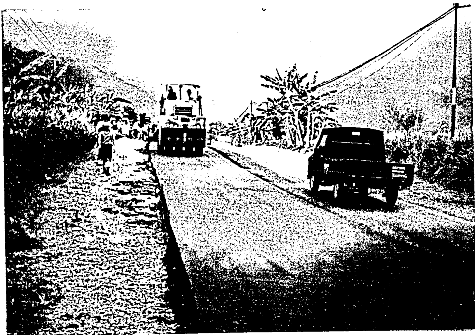
FOTO PEMADATAN KEDUA DENGAN MESIN TIRE ROLLER
