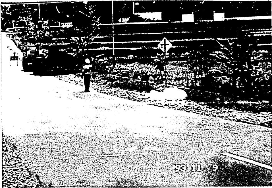
FOTO LOKASI JALAN PERCOBAAN PENGHAMPARAN GEOKOMPOSIT
