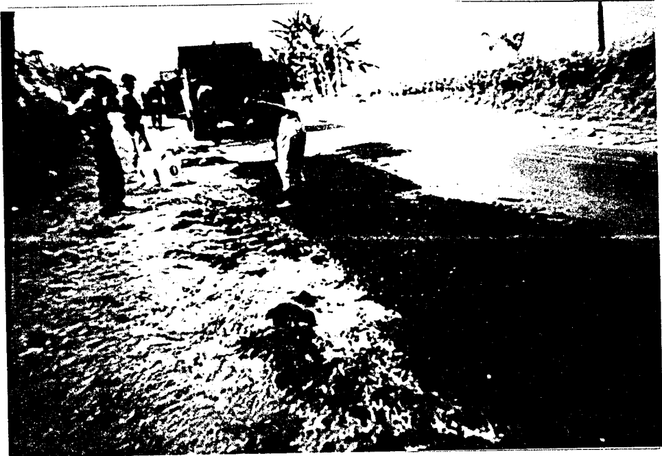
FOTO PENAMBALAN BAGIAN-BAGIAN JALAN YANG MENGALAMI DEFORMASI
