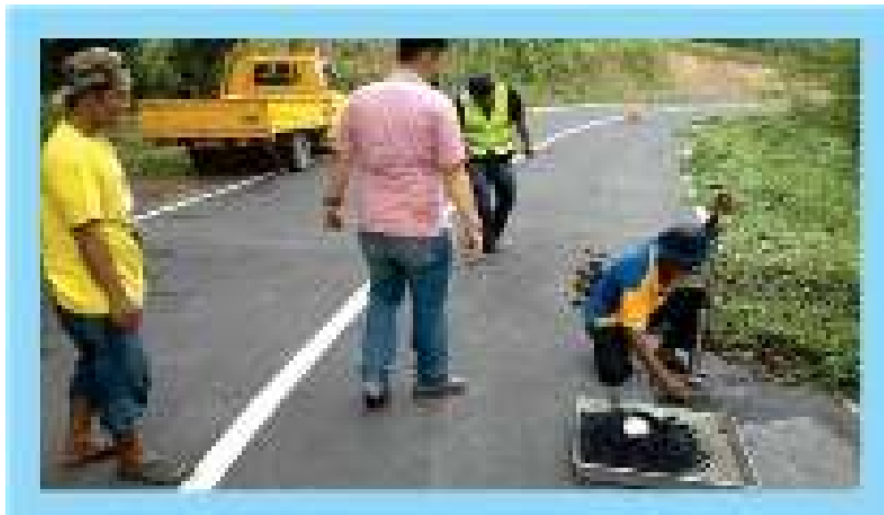
Gambar L-1.11. Penutupan Lubang Bekas Pengambilan Benda Uji Inti
