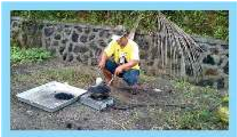
Gambar L-1.10. Penyaiapan Campuran Beraspal untuk Penutupan Lubang
