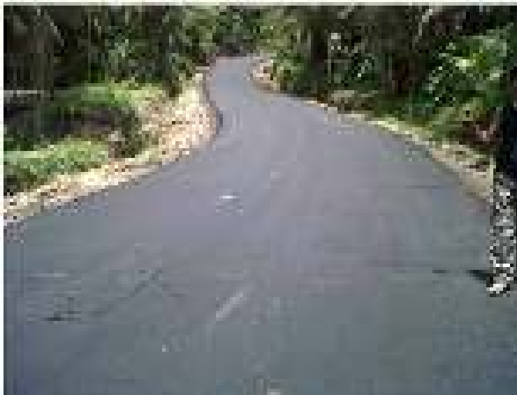
Gambar 4.13. Hasil Penghamparan Uji Coba Skala Terbatas Agregat Substandar Kakaskasen-1, Sulawesi Utara
