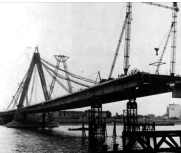
Gambar 21 Contoh ilustrasi pemasangan satu segmen lantai dengan sokongan sementara (Gimsing 1983)
