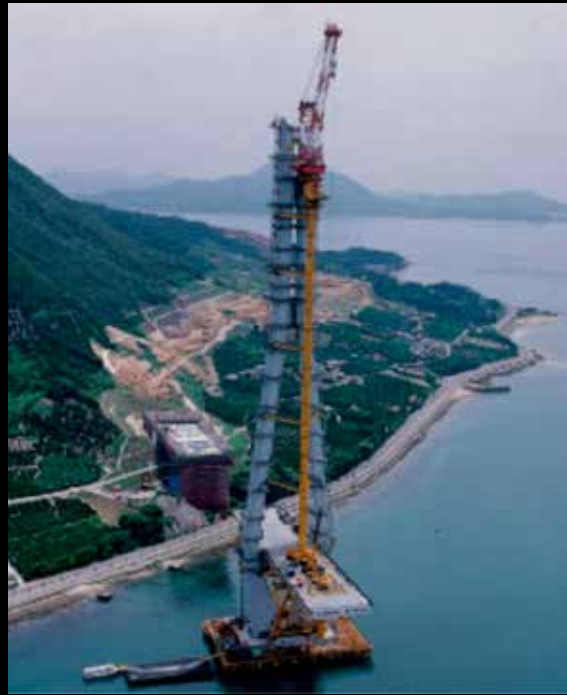
Gambar 26 (kanan) Pemasangan pilon (HSBE)
