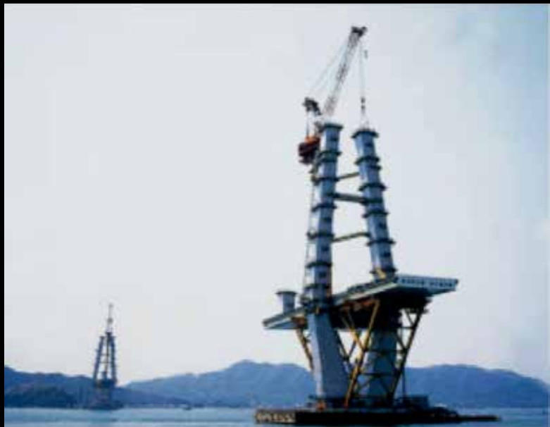
Gambar 26 Pemasangan pilon (HSBE)
