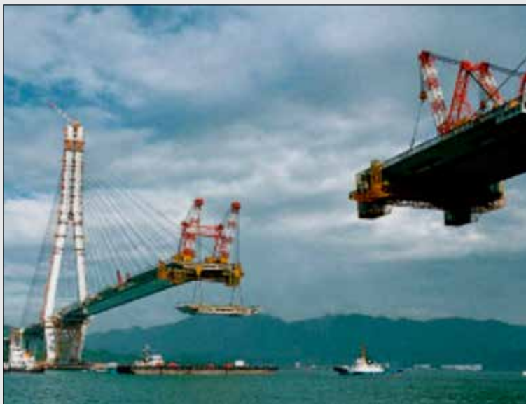
Gambar 27 Pemasangan segmen lantai dengan kantilever bebas berimbang (HSBE)
