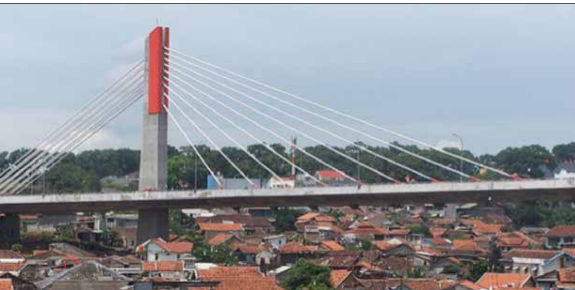
Gambar 4 Jembatan Pasupati, bentang utama 106 m dan total 161m, menara dan gelagar dari beton, prinsip kabel kaku
