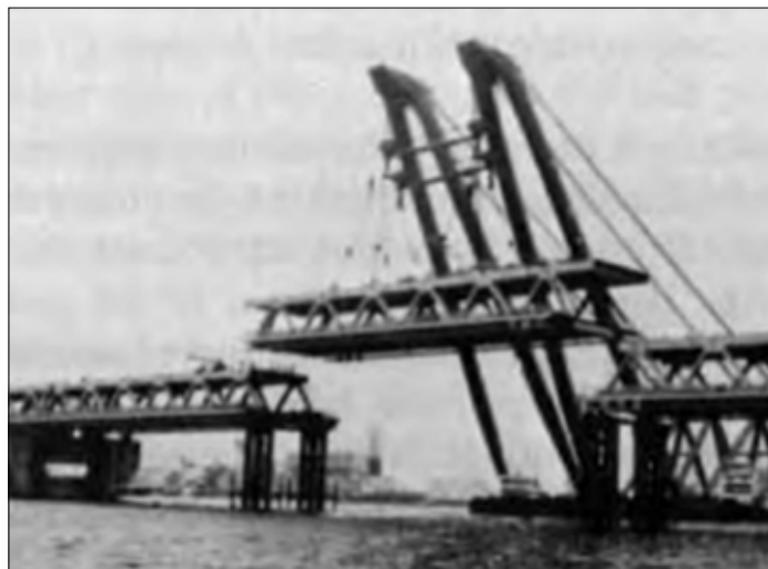
Gambar 22 Contoh ilustrasi pemasangan satu blok segmen lantai dengan sokongan sementara (Gimsing 1983)
