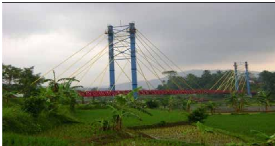
Gambar 7 Jembatan lalu lintas ringan, bentang 240 m dengan lebar bersih 2,5 m di Sukabumi. beban gandar maksimum 3 ton, prinsip gelagar kaku + menara tinggi + kabel ekonomis
