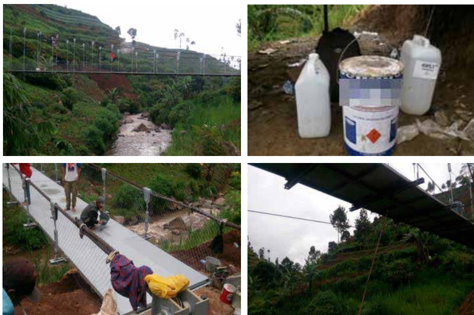
Gambar 4.25 Pengecatan Jembatan
