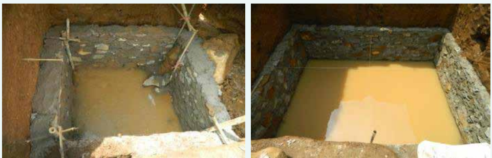
Gambar 4.9 Bekisting pasangan batu untuk pondasi
