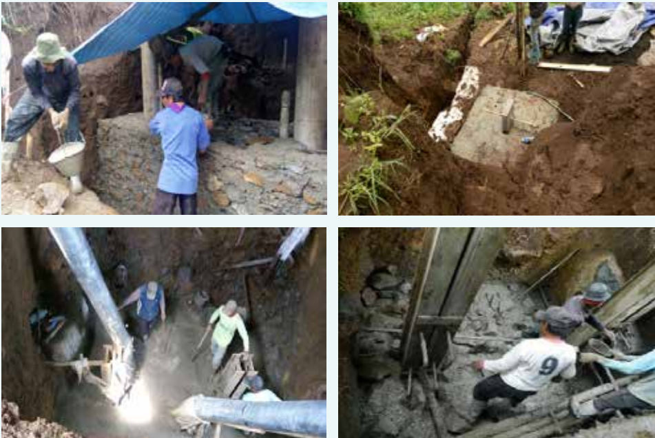
Gambar 4.11 Pengecoran pondasi
