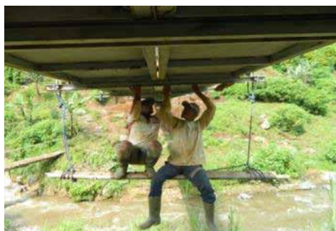
Gambar 4.19 Pemasangan gelagar dan panel lantai
