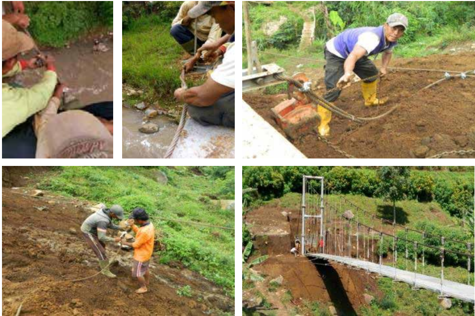
Gambar 4.22 Pemasangan Ikatan Angin
