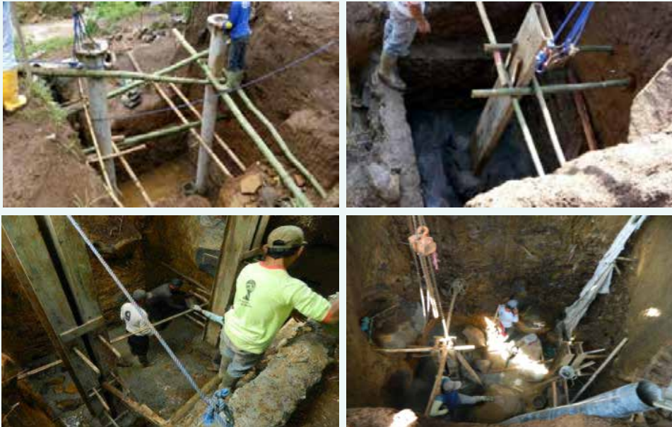
Gambar 4.10 Setting angkur pondasi jembatan gantung
