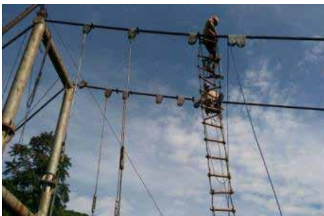
Gambar 4.17 Pemasangan Clamp dan Hanger
