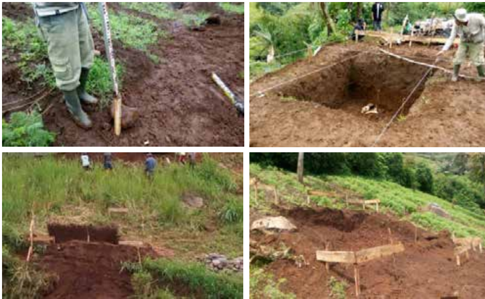
Gambar 4.6 Contoh pengukuran as dan pemasangan bouwplank pondasi
