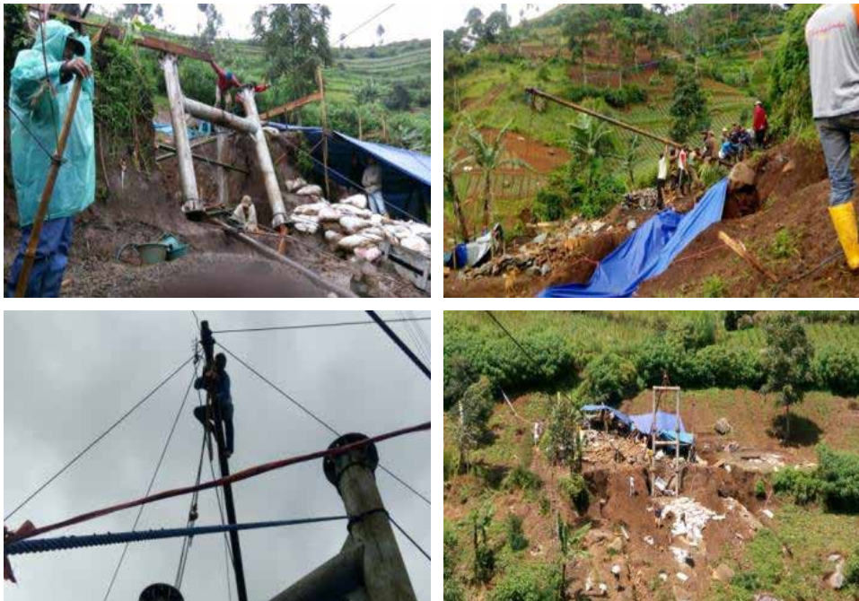
Gambar 4.13 Setting segmen pilon bagian atas
