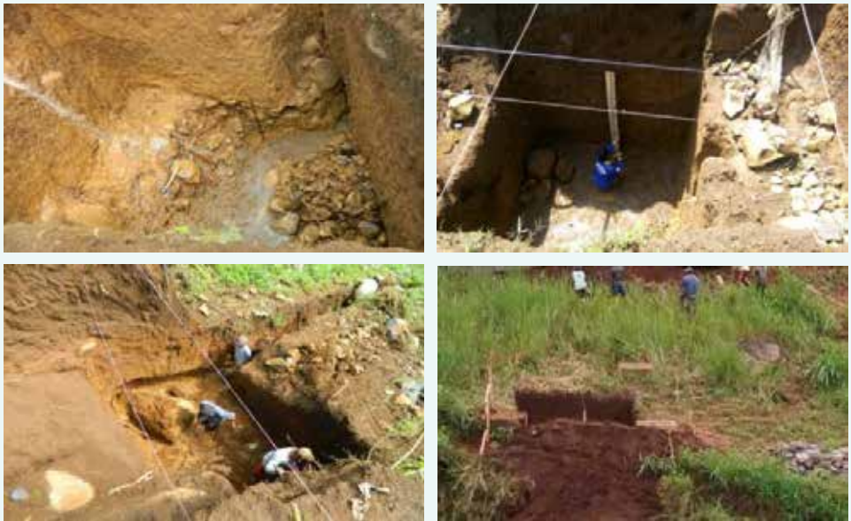
Gambar 4.7 Galian tanah untuk pondasi
