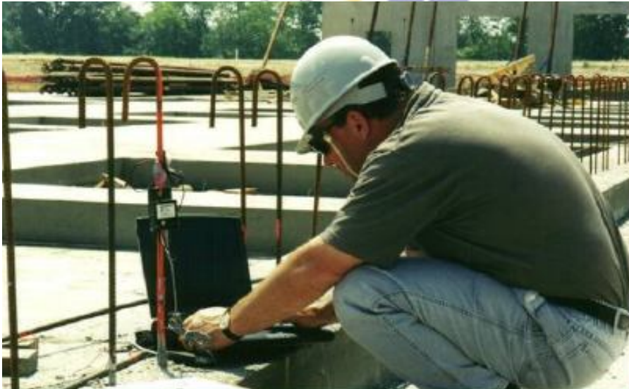
Gambar 34. Pemantauan maturity perkerasan beton di lapangan
