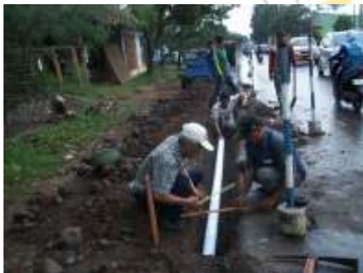
Gambar 21. Pemasangan pipa sub drain, ditempatkan di ujung perkerasan jalan, di bawah lapis ATPB
