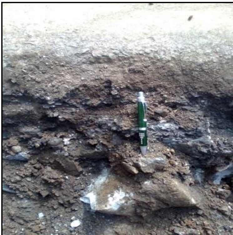
Gambar 19. Tebal perkerasan yang ada, batu belah 15-20 cm, PMA 6 cm, AC 9 cm. Tanah dasar tanah merah.
