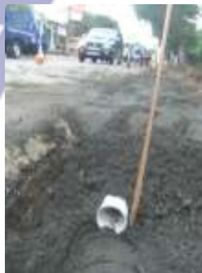
Gambar 22. Drainase subdrain memanjang
