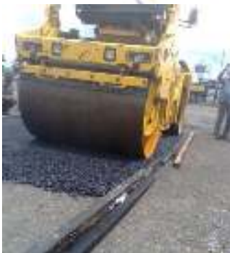
Gambar 29. Pemadatan awal campuran ATPB trial. Campuran tidak bergeser dan perilaku campuran stabil waktu dipadatkan
