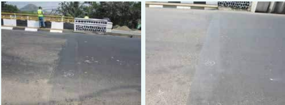
Gambar A.11 Sambungan Siar Muai
