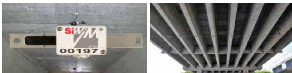
Gambar 3.12 Instrumentasi sistem Bridge WIM pada jembatan dan culvert
