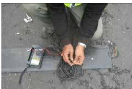
Gambar 3.6 Sensor WIM Strip yang dipasang di perkerasan jalan
