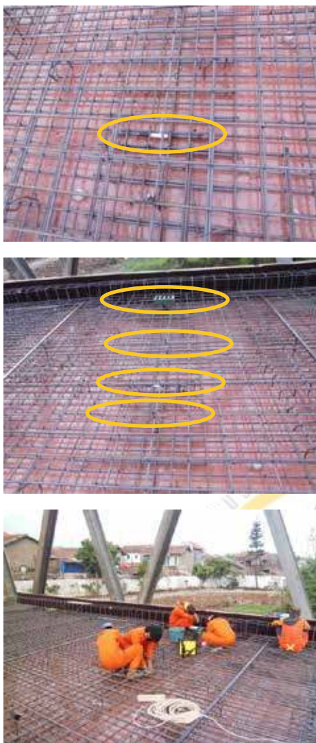
Gambar 9.2 Dokumentasi kegiatan pemasangan sensor strain gage di Jembatan GEOSAN
