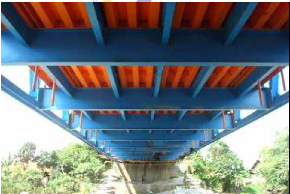
Gambar 2.4 Jembatan dengan Pelat Ortotropik (Bogor)
