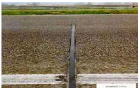
Gambar 3.5 Sensor Piezoelectric yang dipasang di perkerasan jalan
