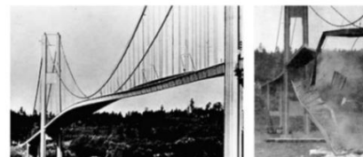
Gambar 2. Jembatan Tacoma I yang runtuh
