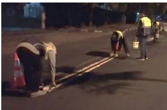
Gambar 2. Pengcatan Cat Tembok dengan Cetakan Marka
