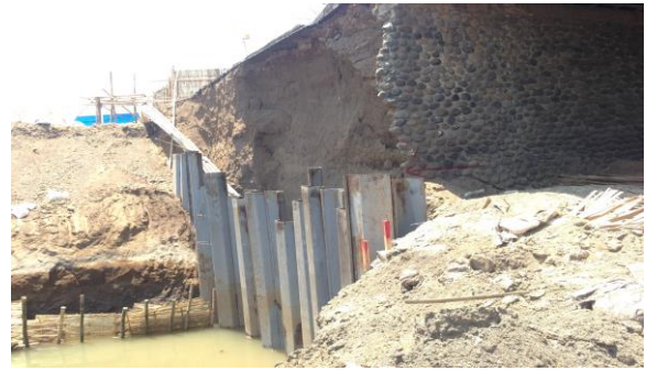
Gambar 15. Penanganan dengan turap ( sheetpile ) menunjukkan gejala keruntuhan timbunan bagian atasnya sehingga turap mulai terdeformasi.
