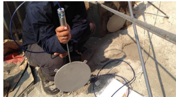
Gambar 18. Pressure cell pada timbunan untuk mengukur defromasi: vertikal timbunan pada tanah dasar dan lateral pada Sheet Pile
