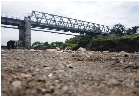
Gambar 2. Kondisi jembatan Cipamingkis setelah perbaikan (Pusjatan 2018)
