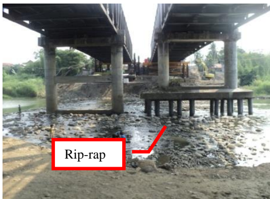
Gambar 4. Penerapan rip-rap pada jembatan Comal
