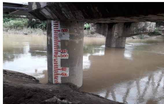
Gambar 3. Kondisi pilar jembatan Cipunegara (Pusjatan 2019)
