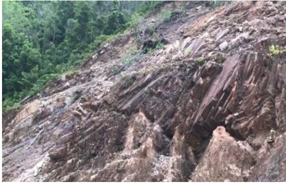
Gambar 6. Kondisi lereng batuan lunak akibat gerusan air permukaan
