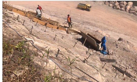
Gambar 8. Pemasangan anker di lapangan
