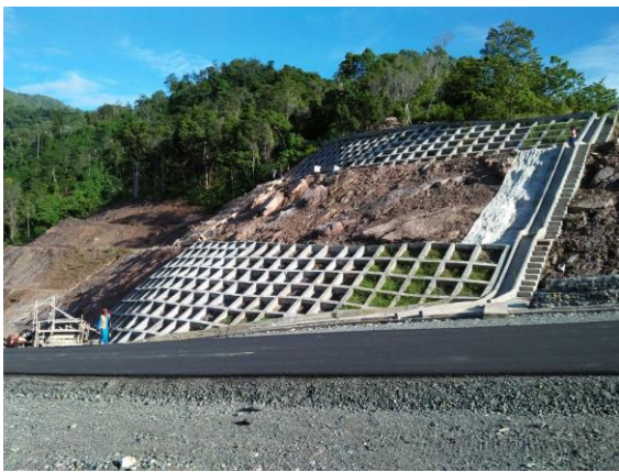
Gambar 14. Penerapan konstruksi Kisi Beton di Gunung Botak, Manokwari, Papua Barat
