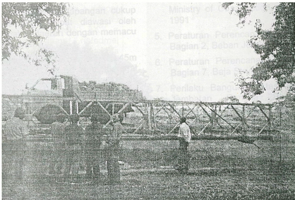
Photo 4. Pengukuran lendutan di ujung kantilever
