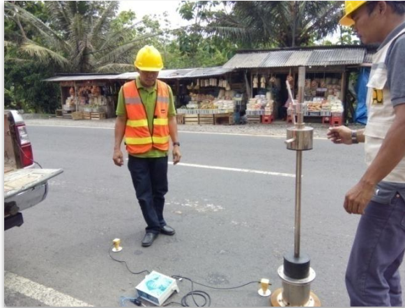
Gambar 1. Satu unit LWD Pusjatan
