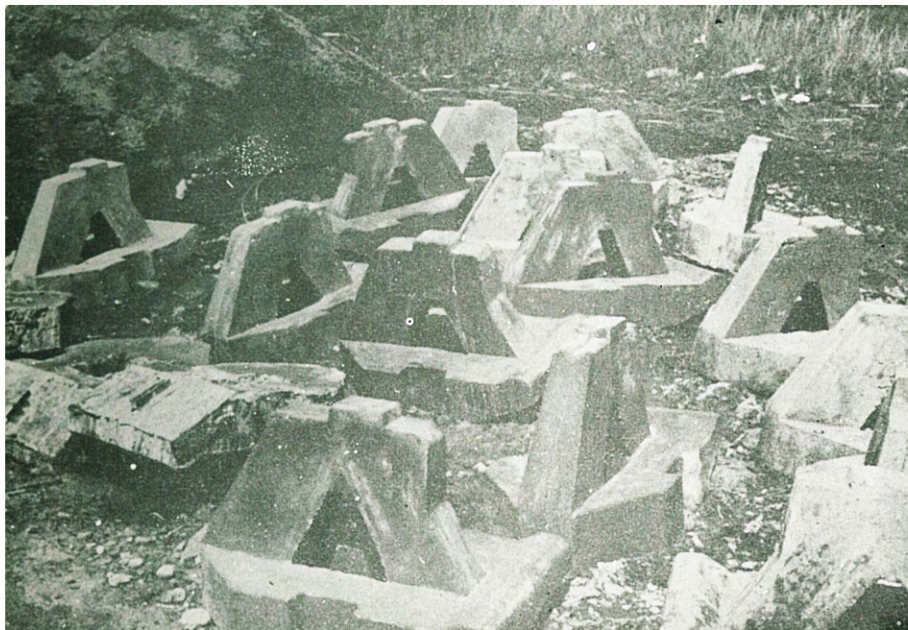
GAMBAR 1 : Beton cetak dengan ukuran : 0,6m x 0,4m x 0,4m
