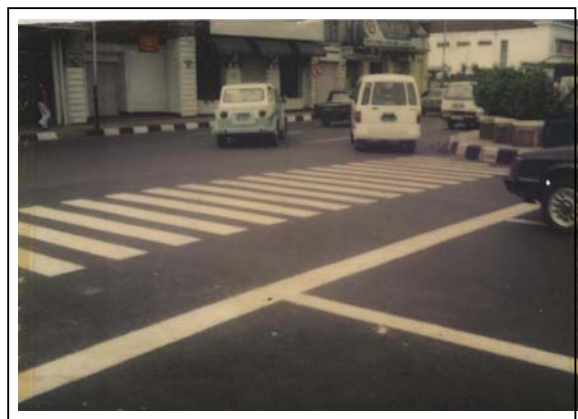
Gambar 2. Lokasi pengamatan jalan Asia Afrika – Braga
