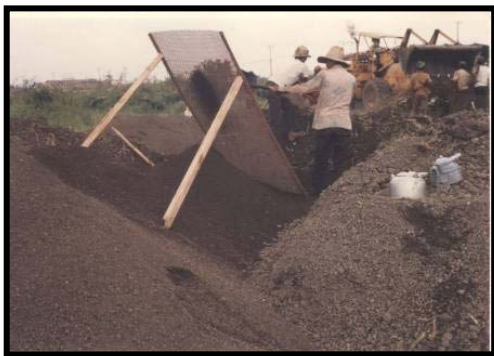
Gambar 1. Penyaringan kembali Asbuton Konvensional
