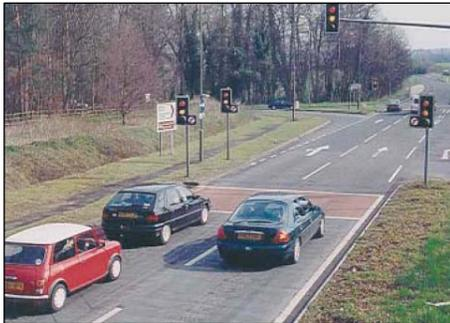
**Gambar 8.** Advance Stop Line (ASL) untuk sepeda
