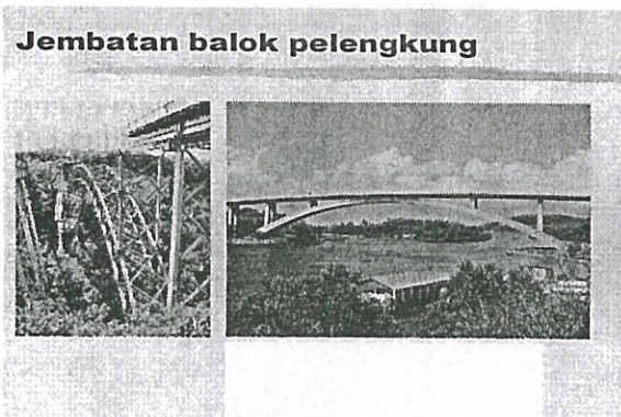
Gambar 12. Jembatan Bareleng, pelengkung beton bertulang komposit, bentang utama 245m
