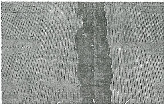
Gambar 9d. Joint No.4 (setelah di-grouting dan diisi *Sealant*)
