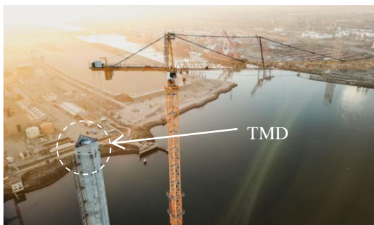
Gambar 3. TMD pada puncak pilon jembatan Gerald Desmond Bridge, California (www.gerbusa.com 2018)
