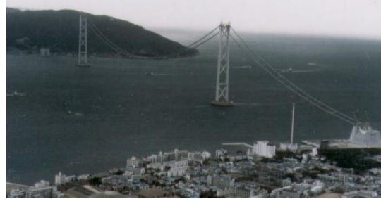
Gambar 1. Jembatan Akashi Kaikyo pada masa konstruksi (Saeki et al. 1996)
