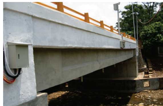
Gambar 3. Tampak Memanjang Jembatan Sinapeul
