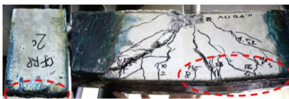
Lapis 2(c) Delaminasi FRP pada ujung FRP (Slip bonding) dengan Critical Diagonal Crack (CDC) akibat retak lentur
