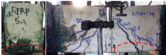
Lapis 5(a) Delaminasi FRP pada ujung FRP ( Slip bonding ) dengan Critical Diagonal Crack (CDC) akibat retak lentur
