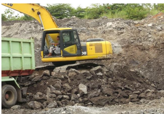
Gambar 1. Deposit Asbuton di Kabungka Buton
