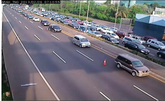
Gambar 2. Kondisi segmen jalan tol Jakarta-Tangerang km. 06+200
