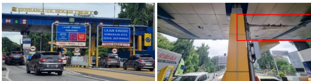
Gambar 3. Lajur khusus Let It Flo dan Reader RFID di gerbang tol
