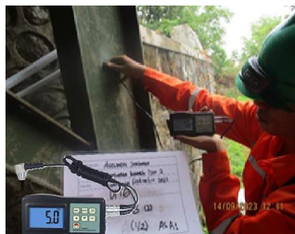
Gambar 6. Ultrasonic thickness gauge pada kolom pilar portal
