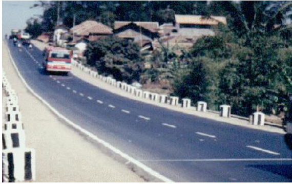
Gambar 1. Percobaan Lapangan Laston Tahun 1993 di Cileunyi, Bandung-Jawa Barat (Umur 10 tahun) (Dachlan AT, 2007)
