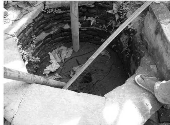
(a) sand boiling pada sumur warga
