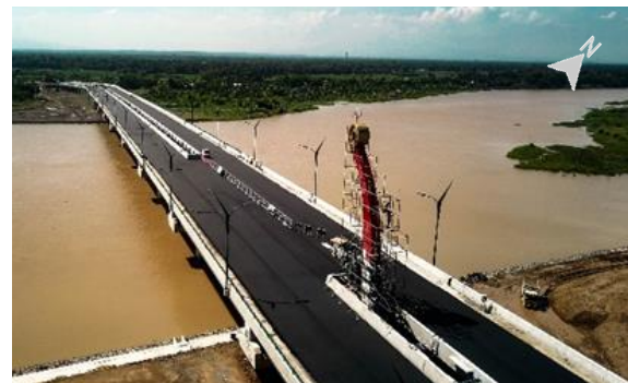
Gambar 5. Bird view pembangunan Jembatan Kretek 2 (Zakariya 2022)
