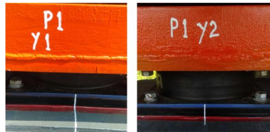
Gambar 5. Kondisi LRB pada pilar jembatan
