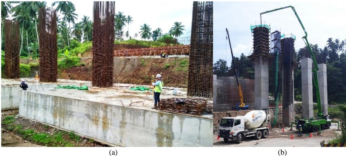
**Gambar 1.** (a) struktur *pilecap* (b) struktur *pier*, keduanya termasuk beton bervolume besar.
