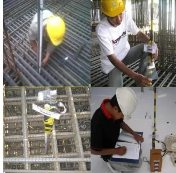
**Gambar 6.** Pemasangan *thermocouple* pada beton dan pembacaan temperatur
