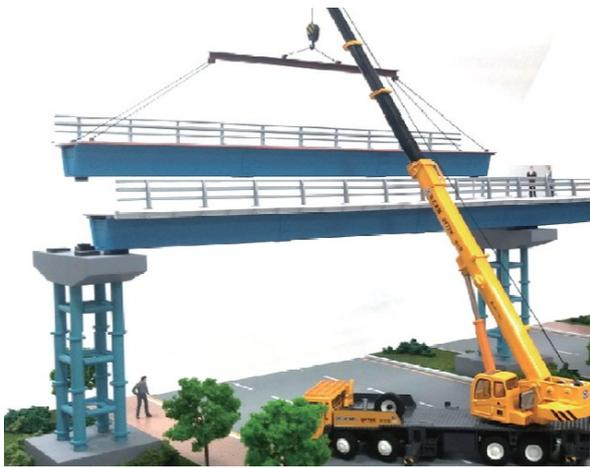
**Gambar 6.** Ilustrasi pekerjaan peluncuran gelagar boks baja modular untuk lintas atas jalan eksisting (Pusjatan 2016a)
