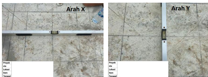
Gambar 4 Pengecekan Kerataan Mortar Pad
