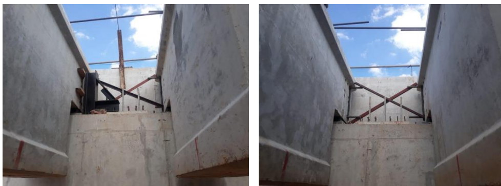
Gambar 11 Pemasangan Cross Bracing pada Girder
