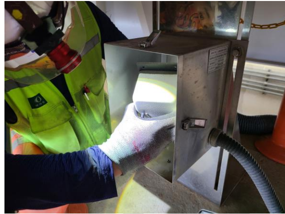
(b) Pencabutan sensor yang ada
