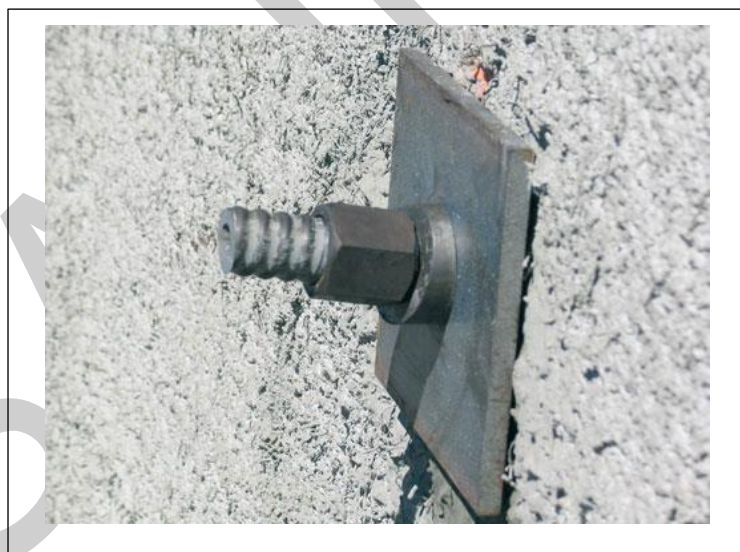
Gambar SKh3.7.19.5) Pelat Penumpu ( Bearing Plate ) dan Mur Pengunci ( Hex Nut )
