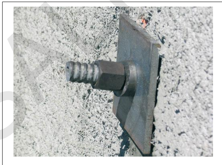
Gambar SKh-2.7.19.5) Pelat Penumpu (Bearing Plate) dan Mur Pengunci (Hex Nut)
