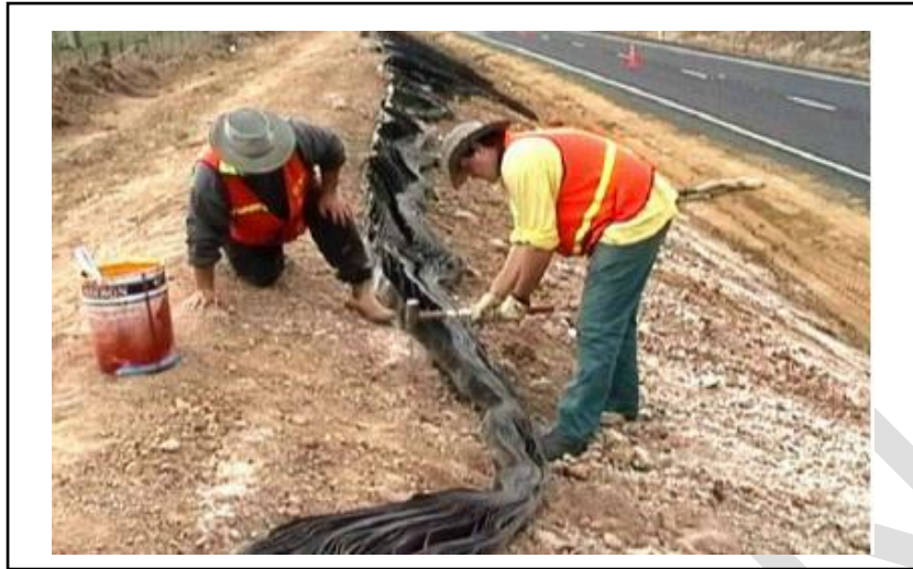
Gambar SKh.1.3.23.4) Persiapan Unit Geocell pada Puncak Lereng
