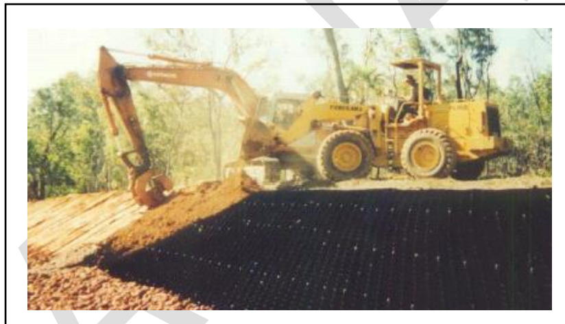
Gambar SKh.1.3.23.7) Penghamparan Tanah ke dalam Geocell
