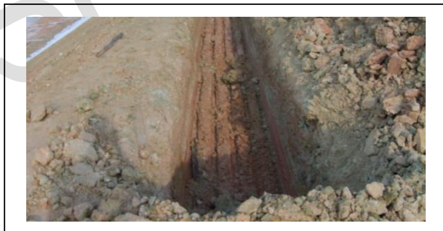
Gambar SKh.1.3.23.3) Galian Parit Pengangkuran Tepi Atas Pemasangan Geocell
