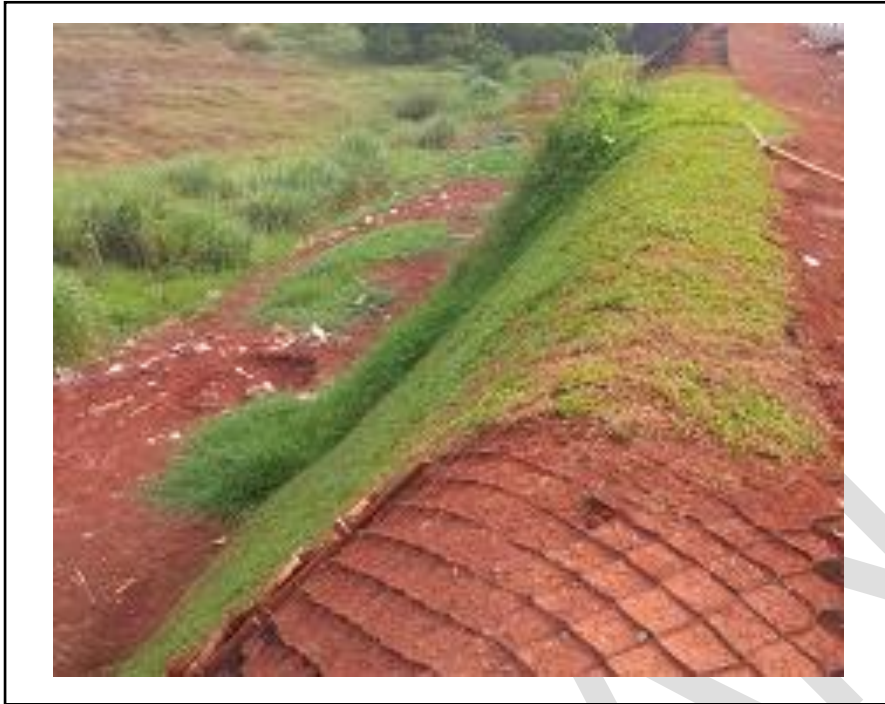
Gambar SKh.1.3.23.8) Pemasangan Geocell Selesai Dilanjutkan Proses Vegetasi
