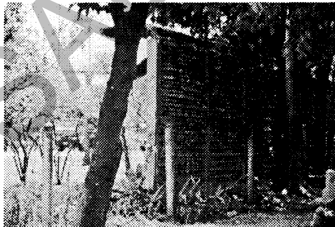
Gambar 2. Dinding Peredain Bising yang terbuat dari Bata Merah
