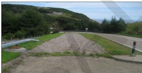
Gambar 4 - Jenis jalur penghentian darurat dengan landasan penghenti menanjak
