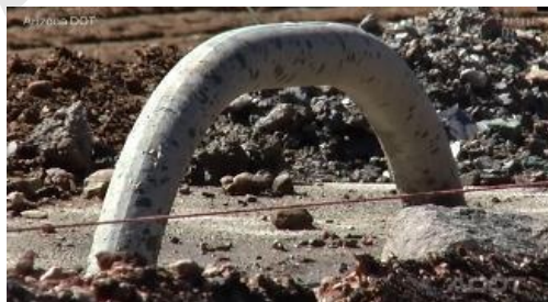
Gambar 24 - Contoh angkur pada jalur penghentian darurat
