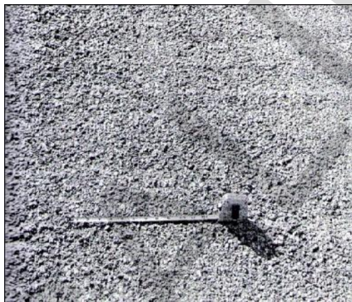
c. Pelepasan butir (raveling)
