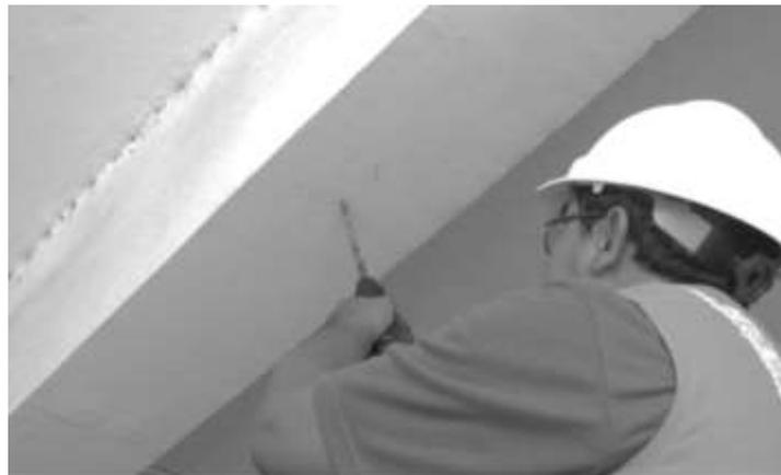
**Gambar 13 - Pembuatan lubang untuk dudukan transduser regangan**
