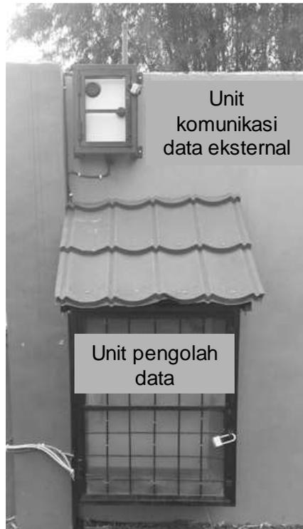
**Gambar 18 - Pemasangan unit pengolah data dan unit komunikasi data eksternal**
