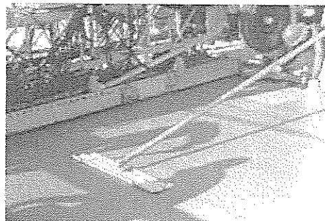
Gambar 56 Penekanan alat pelepa (Bull float)
