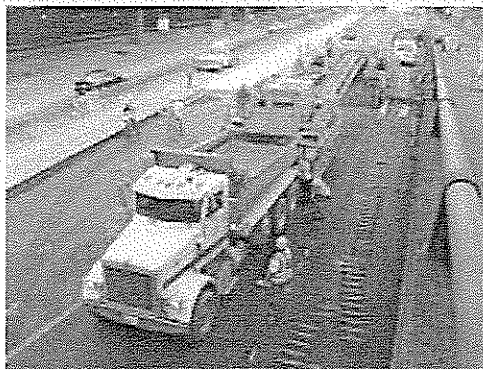
Gambar 23 Placer/spreader menerima beton segar dari dump truk dan menempatkannya di depan penghampar ( paver ).
