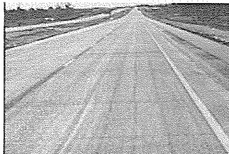
Gambar 50 Goresan vibrator yang tidak bekerja dengan benar.
