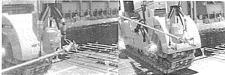
Gambar 39 Sensor elektronik pada acuan bergerak
