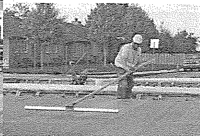
Gambar 19 Tining secara manual
