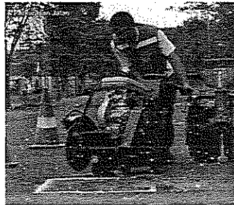
A.1b - Pemotongan perkerasan yang akan diperbaiki
