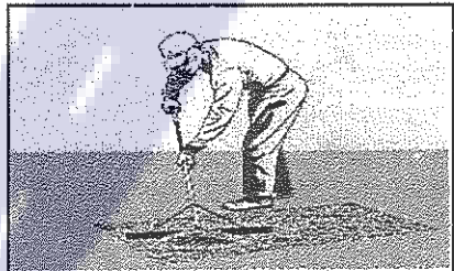
3f - Pengisian lubang dengan campuran beraspal dan perataan
