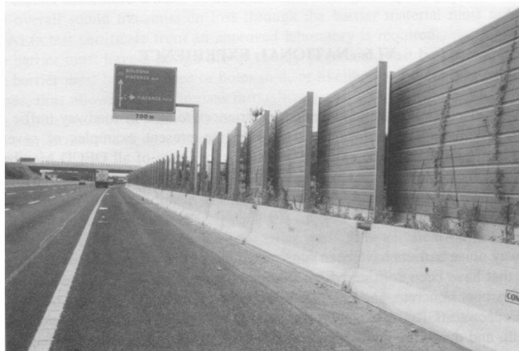
Gambar C.5 Penghalang tidak menerus alumunium
