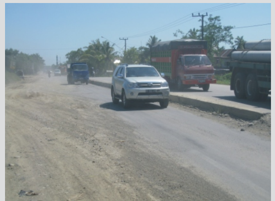
Penahapan pekerjaan jalan ini mempunyai banyak area kerja, masing-masing ada undakan perkerasan beton baru. Tanpa perambuan, setiap undakan memberikan kejutan bagi pengguna jalan.
