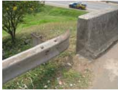
Gambar 4.8 Sambungan yang tidak baik.
