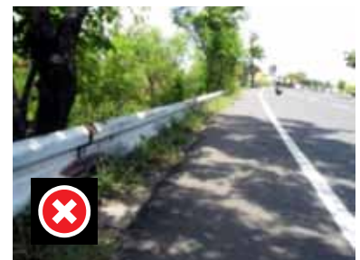
Tumpukan sambungan yang salah Terlalu rendah Tidak cukupnya jarak ke hazard pohon
