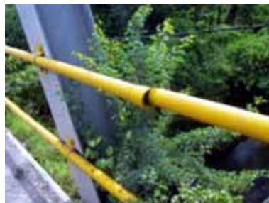
Pagar pada jembatan perlu dipelihara sehingga dapat terus-menerus berfungsi dengan baik. Ujung pagar juga berpotensi menciptakan bahaya 'tertusuk' jika terjadi benturan/tumbukan.
