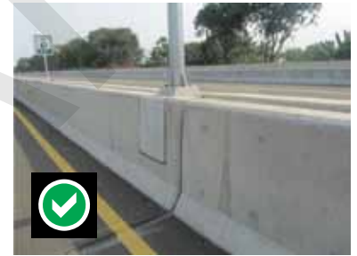
Tiang lampu ini dipasang pada bagian atas pagar. Hal ini untuk tetap mempertahankan pagar yang berkesinambungan.
