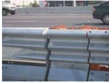
Gambar 4.6 Pagar besi seperti pada contoh ini telah diuji TL-3 untuk menutup median di jalan berkecepatan tinggi. Ketika bukaan diperlukan dalam keadaan darurat atau untuk pemeliharaan, petugas jalan yang berwenang membuka kunci pagar dan meninggirkannya.
