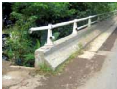
Gambar 4.7 Pagar jembatan kurang baik. Pagar jembatan ini berbahaya karena pagar dapat menusuk ke dalam kendaraan. Sambungan pagar ke parapet jembatan tidak menerus, dan pada kecelakaan pagar akan berdefleksi dan menyebabkan kendaraan masuk 'terjepit' ke ujung parapet jembatan.
