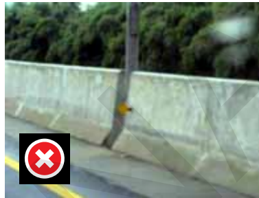
Tiang lampu dalam pagar beton ini membuat celah yang dapat menjadi bahaya lekukan jika ditabrak oleh kendaraan berkecepatan tinggi.
