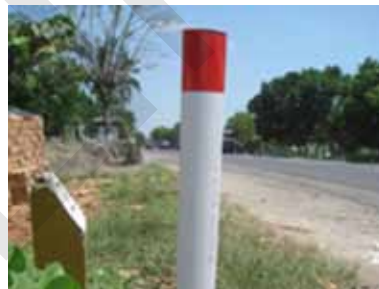
Patok pengarah plastik yang dibuat dengan memotong pipa PVC menjadi dua dan menempelkan reflektor di atasnya.
