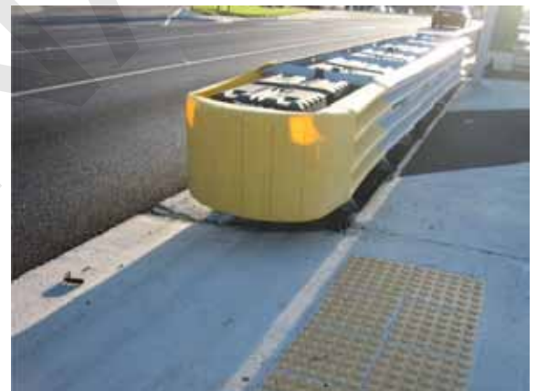
Gambar 3.24 Ujung pagar beton ditutupi dengan Bantalan Tabrakan.
