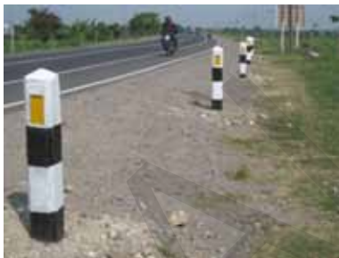
Patok pengarah beton bertulang memberi delineasi yang baik, tetapi merupakan hazard yang tidak perlu di sepanjang sisi jalan.
