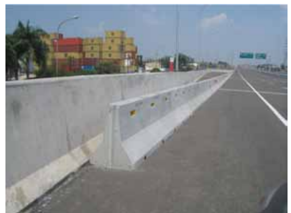
Gambar 3.35 Pagar beton sementara telah tersambung dengan baik. Namun ujung dari pagar ini adalah hazard bagi penumpang kendaraan yang lepas kendali. Pagar permanen di belakangnya bahkan dapat mengarahkan kendaraan lepas kendali pada ujung tumpul ini.
