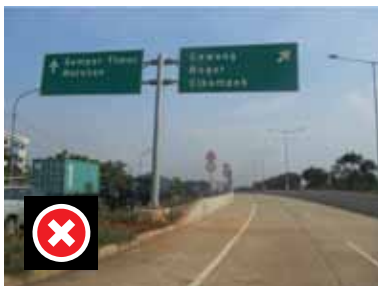
Gambar 4.2 Tiang rambu pada foto di atas berbahaya bagi kendaraan yang lepas kendali.
