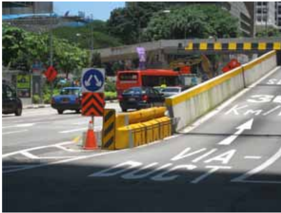
Gambar 3.36 Bantalan tabrakan berbiaya murah merupakan salah satu opsi sebagai terminal berkeselamatan pagar kaku sementara.
