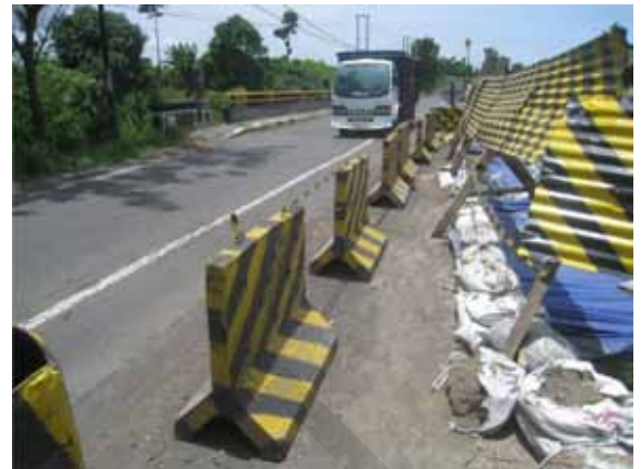
Gambar 3.31 Balok beton ini memberikan delineator yang baik tetapi merupakan bahaya apabila tertabrak. Balok ini tidak memiliki kapabilitas untuk mengembalikan arah kendaraan dan tidak disarankan digunakan sebagai pagar keselamatan.
