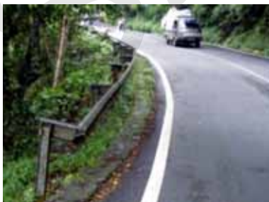
© Bagian pagar keselamatan dengan tiang-tiang yang sudah rapuh dan ketinggalan jaman tidak bisa diharapkan berfungsi secara memadai dalam kecelakaan.
