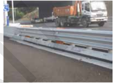
Gambar 4.6 Pagar besi seperti pada contoh ini telah diuji TL-3 untuk menutup median di jalan berkecepatan tinggi. Ketika bukaan diperlukan dalam keadaan darurat atau untuk pemeliharaan, petugas jalan yang berwenang membuka kunci pagar dan meninggirkannya.
