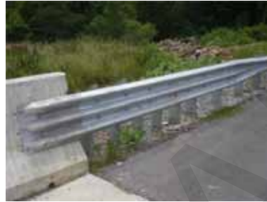
Gambar 4.9 Sambungan yang baik.
