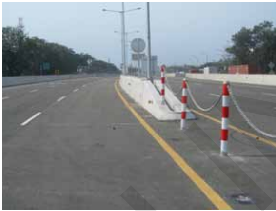
Gambar 3.29 Bukaan median pada jalan bebas hambatan baru ini, memiliki ujung pagar menaik yang tidak aman. Median ini juga dapat digunakan sebagai putar-U karena patok/bollard ini mudah dipindahkan. Pagar baja (lihat gambar sebelumnya) pada bukaan tersebut direkomendasikan sebagai pilihan yang lebih aman.
