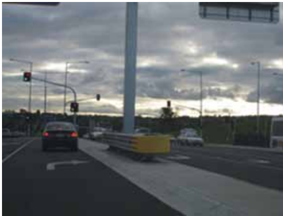
Gambar 3.25 Dua bantalan tabrakan "punggung ke punggung" menutupi tiang rambu besar di median sempit
