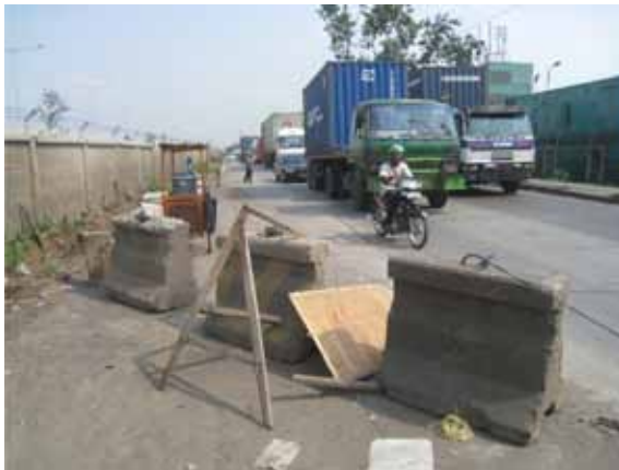
Gambar 3.30 Balok beton ini tidak berkeselamatan. Balok beton ini TIDAK boleh digunakan di jalan.
